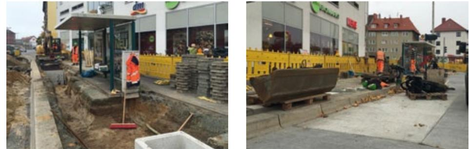
Abbildung 31: Errichtung Ladeinfrastruktur an der Haltestelle Amalienplatz
